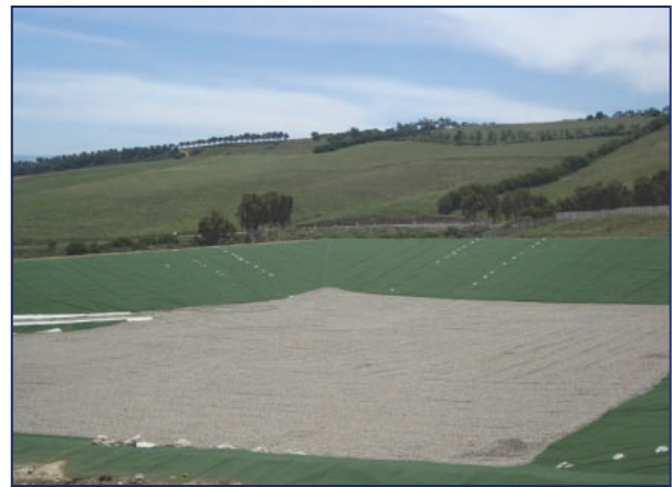
Figure 4. Mise en œuvre du géocomposite.
