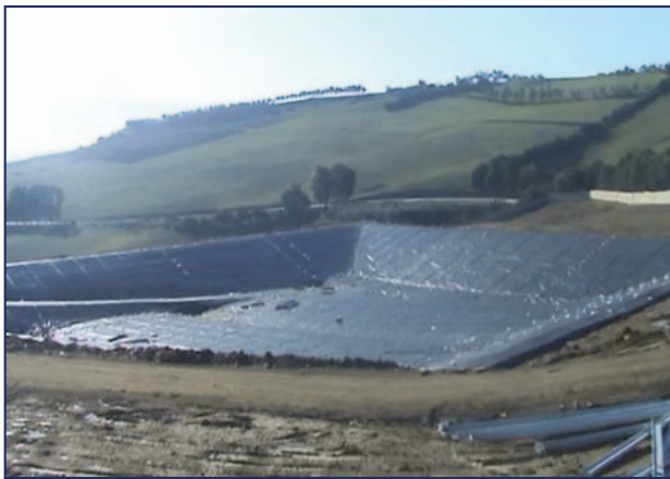
Figure 3. Mise en œuvre de la géomembrane
